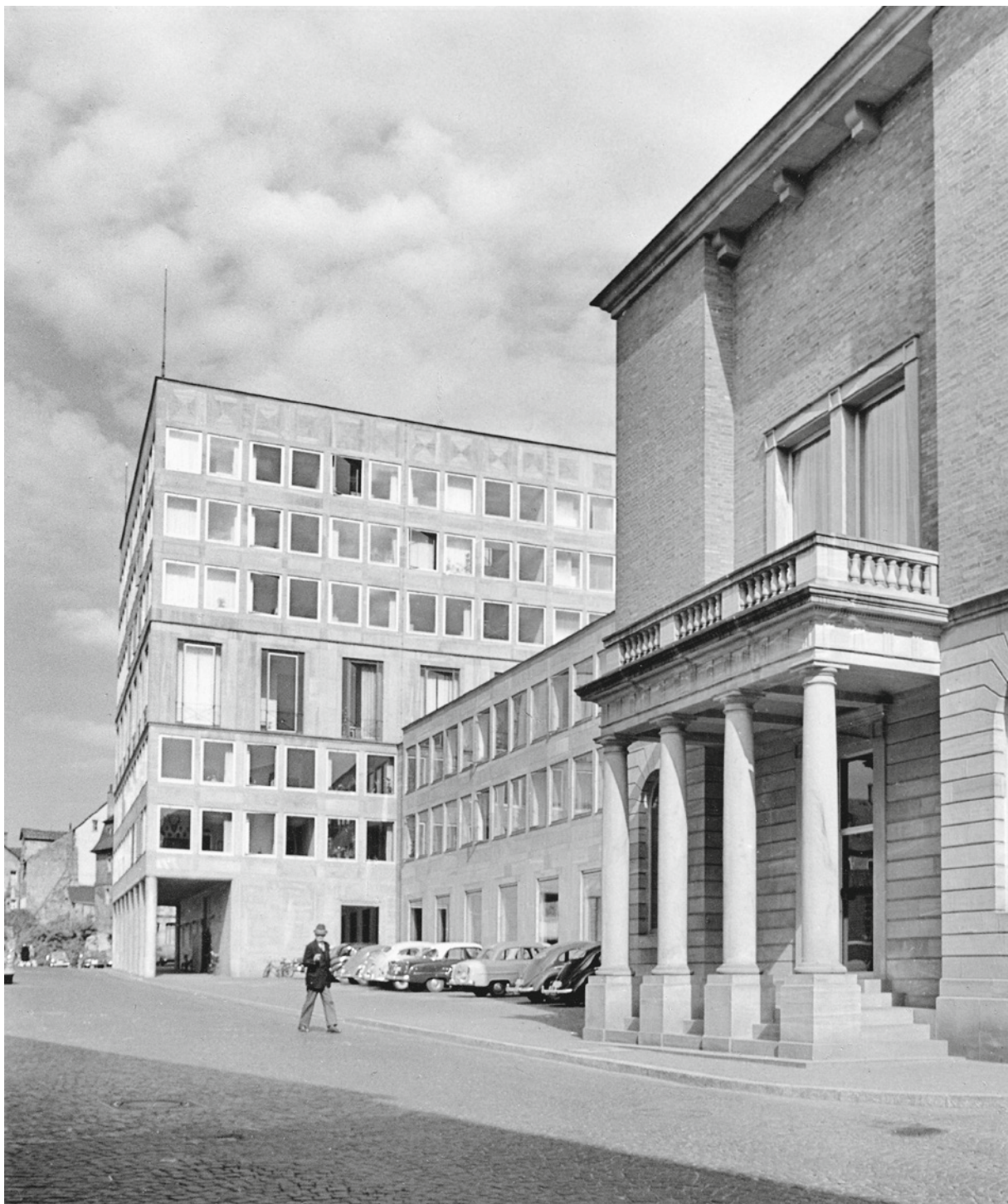
Auf dem höchsten Punkt der Stadt und in direkter Nachbarschaft zur Stiftskirche St. Peter und Alexander liegt das Rathaus – im Bild das 1765 errichtete alte Rathaus (heute Großer Sitzungssaal) und der von 1956 bis 1958 gebaute moderne Neubau. Stadt- und Stiftsarchiv Aschaffenburg, Foto: Niebuhr, Kl. Heseback, 1957.
